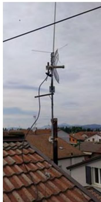
tenna dell'AP. Questa volta ipotizza un possibile disallineamento. Il giorno successivo nonostante il sole e le temperature da coccolone, Fabio interviene sul tetto e in effetti verifica che la staffa si è allentata e si è ruotato il supporto. Ricentrato a occhio il puntamento tutto riparte alla grande!!!. Meno male eravamo preparati al peggio.
