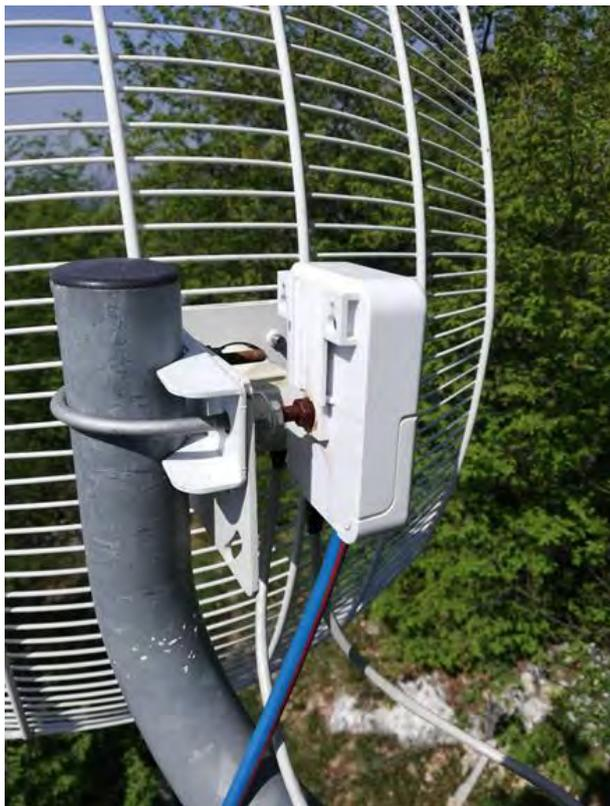
Ha poi fissato per ulteriore sicurezza il cavo con una fascetta alla staffa di sostegno.
